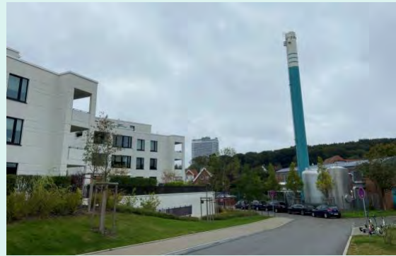
Neubau auf dem früheren Parkplatz „Godewind“, Travemünde
